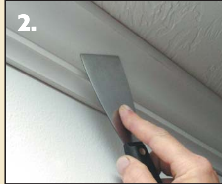
Fill nail holes
